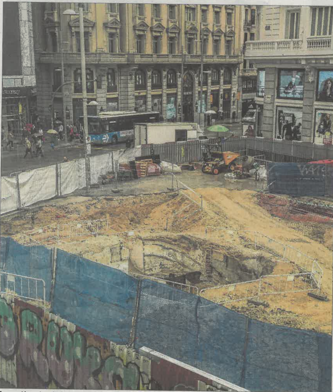
Excavación en la calle Montera para construir el acceso de la parada de Metro de Gran Vía con Sol. OLMO CALVO
